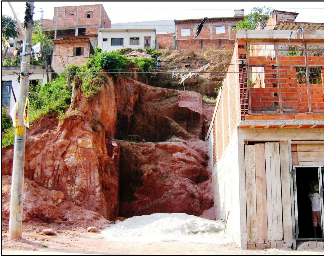
A busca obsessiva por platôs provocado descalçamento sucessivos de jusante para montante
