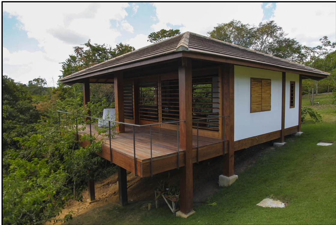
Edificação simples dentro do mesmo conceito
