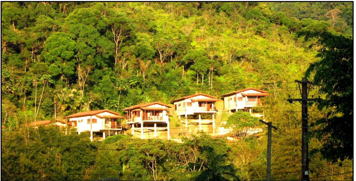
Casas construídas em encosta da Serra do Mar no conceito laje lançada sobre pilotis, ou seja, sem cortes no terreno
